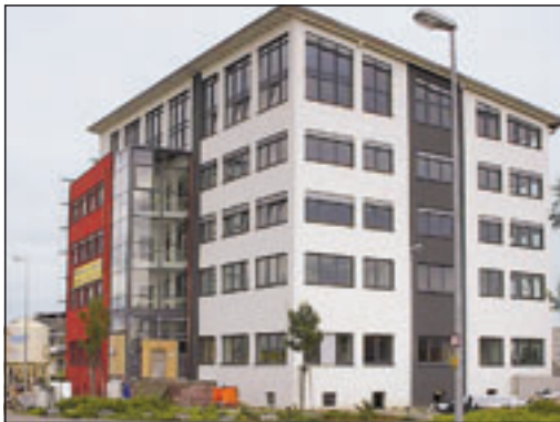
Bild 2a: Büro- und Verwaltungsgebäude (Quelle: S + E Klima Sonder-technik)
