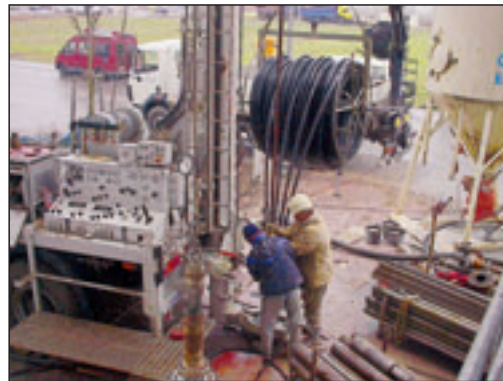
Bild 2c: Erdsonden-einbau (Quelle: S + E Klima Sonder-technik)
