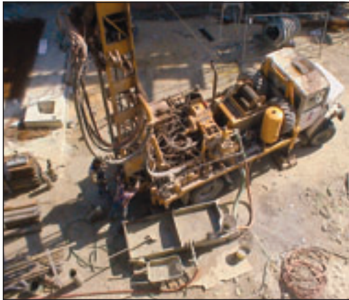
Bild 4c: Erdsonden- bohrung (Quelle: PKi)
