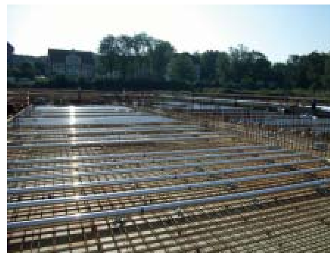
Betonierarbeiten Rohdecke mit Lüftungsrohren
