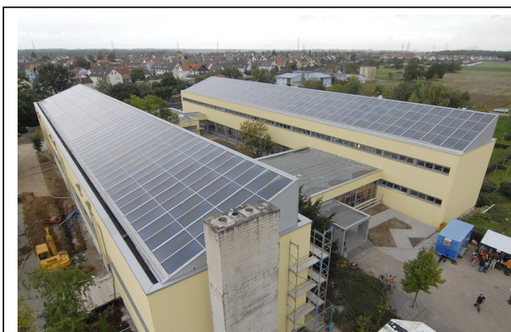
Saniertes Schulgebäude mit 1.000 m 2 Kollektorfläche – Die größte Einzelmaßnahme im gesamten Projekt
