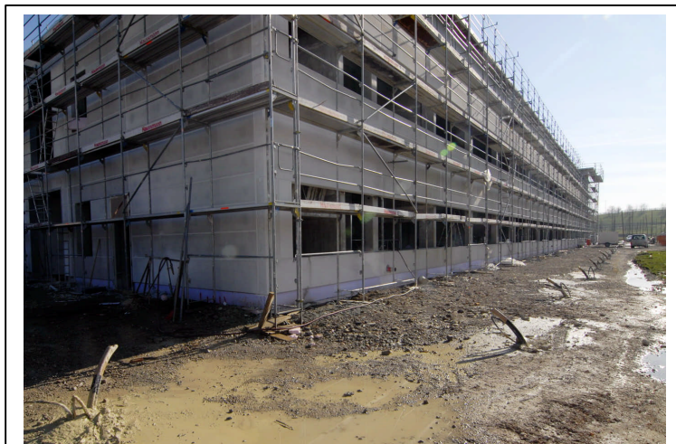
Gebäude und Erdsondenanlage im Bau
