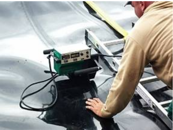
Herstellung der Außenabdichtung Doppelnah mit Schweißautomat
