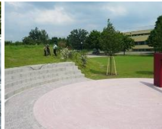
fertiggestellter Speicher in Landschaftsgestaltung integriert
