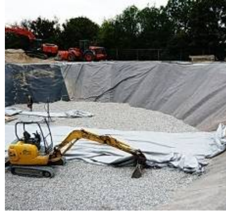
Einbringung untere Kiesebene
