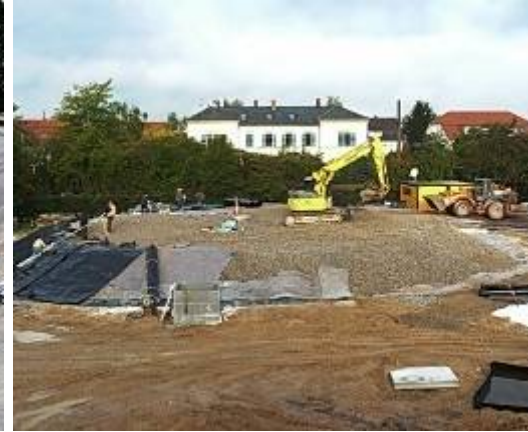
oberste Kiesschicht
