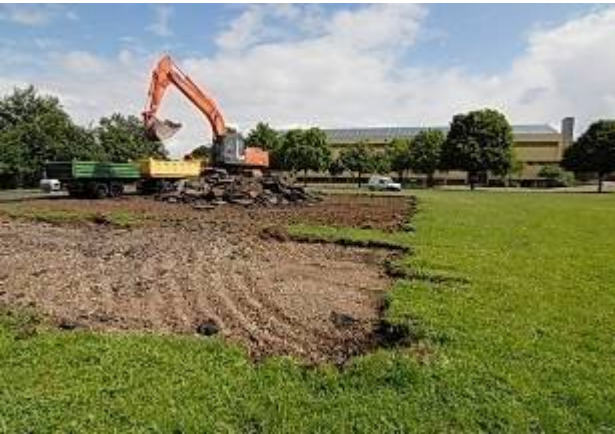
Asphalt entfernen / Oberboden lösen
