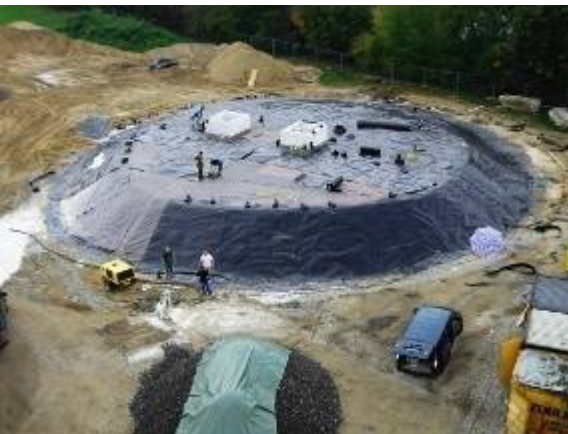
obere Innenabdichtung dampfdiffusionsdichte Sperrschichtbahn
