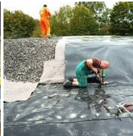
Schweißerarbeiten obere Abdichtung Deckeldämmung
