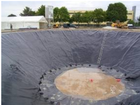
Äußere Abdichtung fertiggestellt
