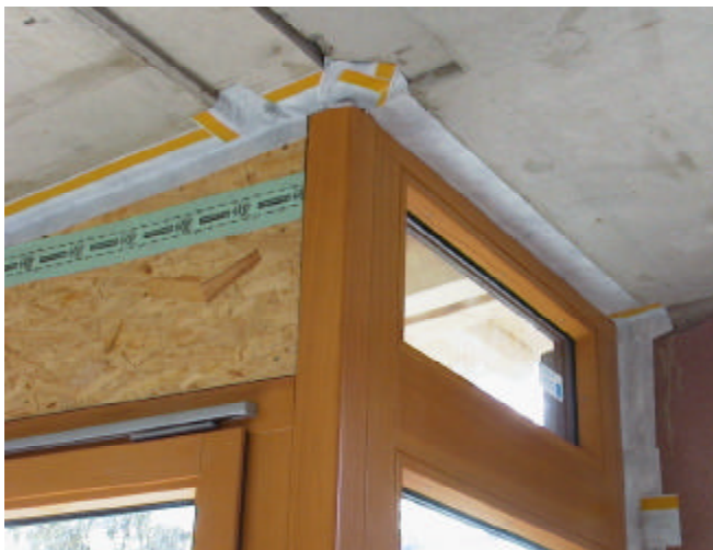
Sorgfältig ausgeführte Anschlüsse von Fenstern und Türelementen
