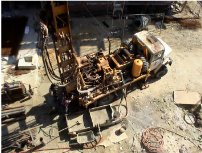
Erdsondenbohrungen bis in 160 m Tiefe
